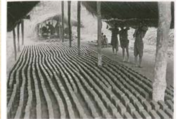
Séchage de briques dans une briqueterie de Yaoundé au Cameroun
