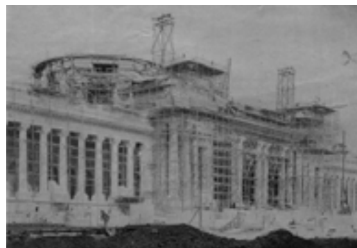
Vue du chantier du Grand Palais. Photographie. 1898-1899.
