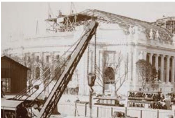
Vue du Grand Palais en construction depuis la Seine. 1899
