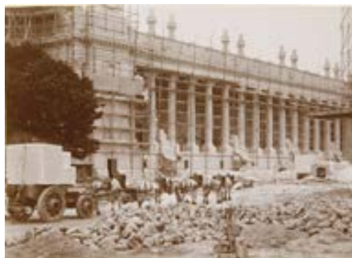
Les travaux du Grand Palais. Photographie. 1898.
