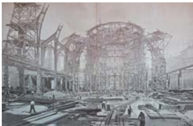
Les échafaudages du dôme. 1898
