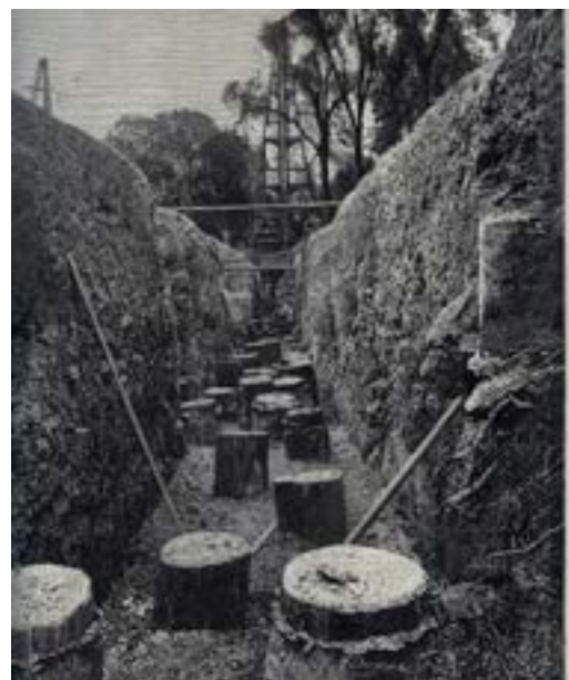
Un alignement de pieux de consolidation du sol. Photographie. 1897.
