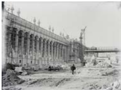
Les travaux du Grand Palais. Photographie. 1898.
