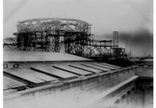
Échafaudage du dôme. Photographie. 1899.
